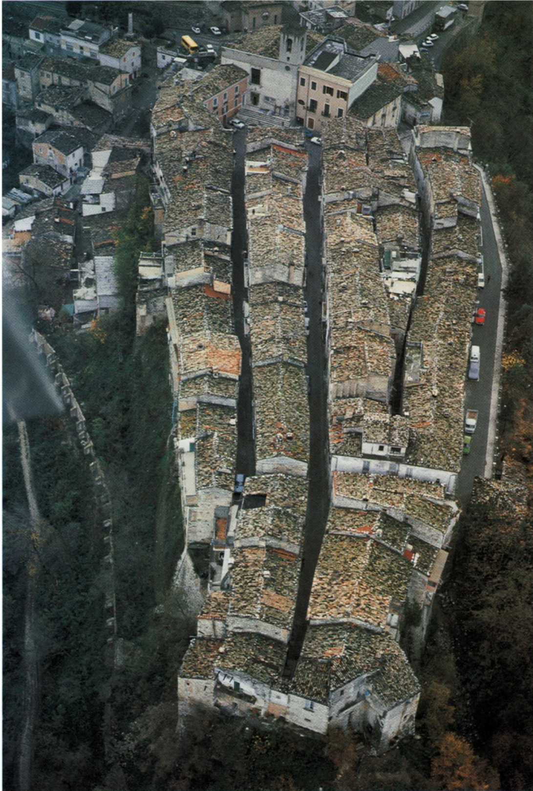
4. Castelli, la struttura del nucleo centrale.
