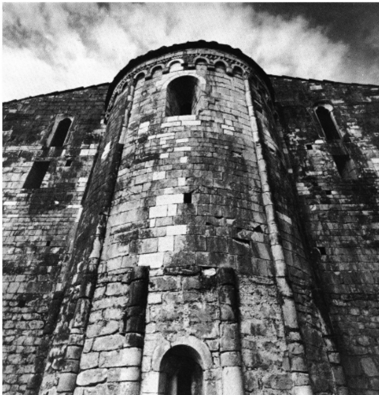
101. San Giovanni ad Insulam. Lato posteriore.
